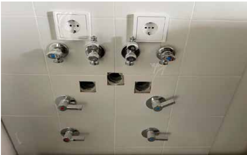
Llaves de corte general de la cocina. Situadas debajo del fregadero.
