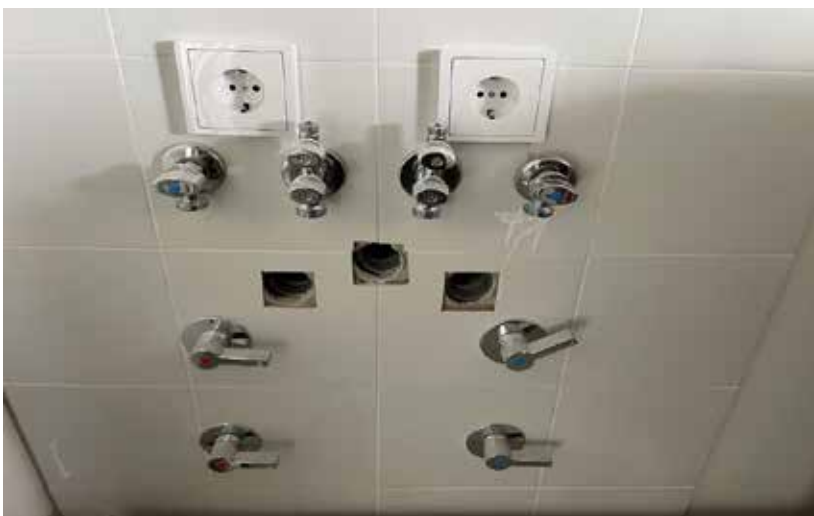
Llaves de corte para fregadero, lavadora (*) y lavavajillas
