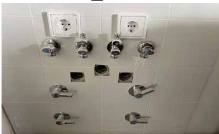
Llave de corte de agua fría para terraza en registro baño
