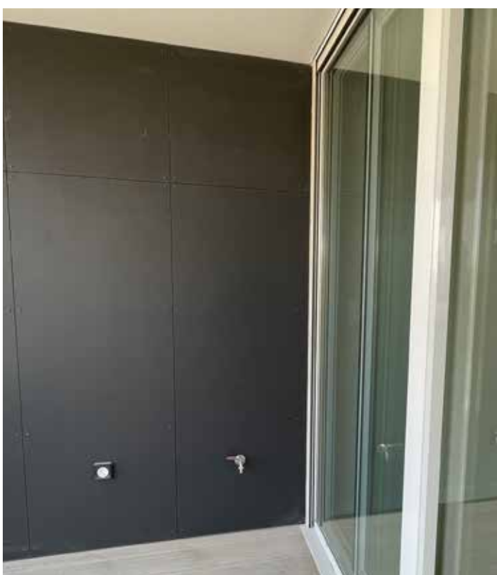
Llave de corte de agua fría para terraza en registro baño
